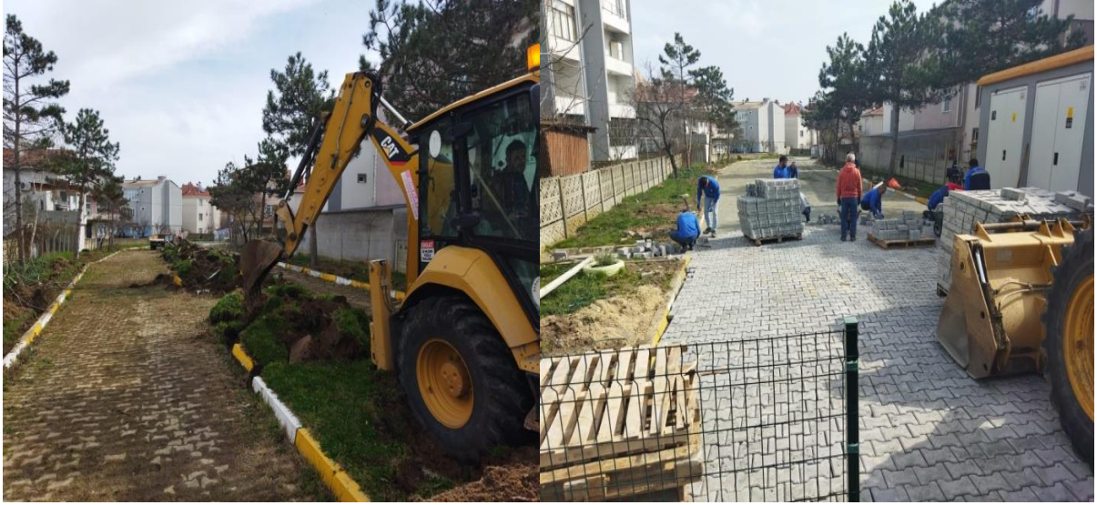
Güneşkaya Parkı'na aydınlatma hattı çekilip, 3 adet büyük, 10 adet küçük, toplam 13 adet aydınlatma direği montajlanarak, zemin ve çevre düzenlemesi yapılmıştır.
