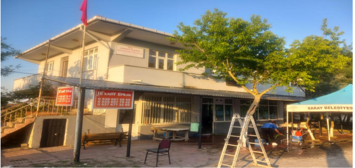
Bahçedere Mahalle Muhtarlığı Binası önü Sandviç Panel Montajı
