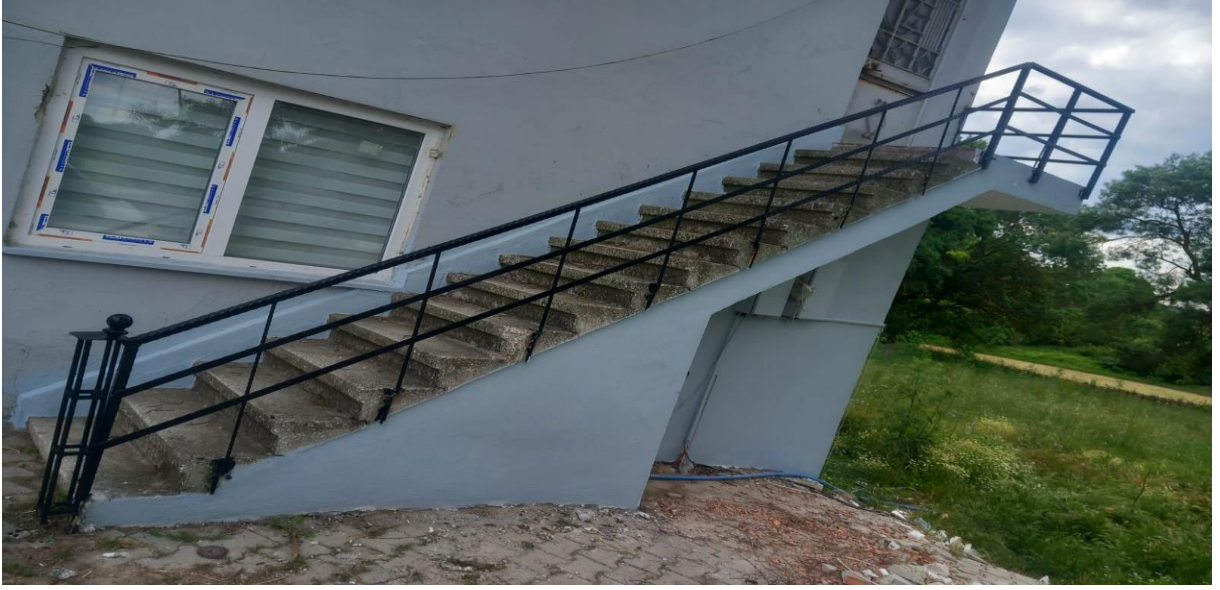
Ayvacık Mahalle Muhtarlığı Binası Merdiven Korkuluęu Yapımı
