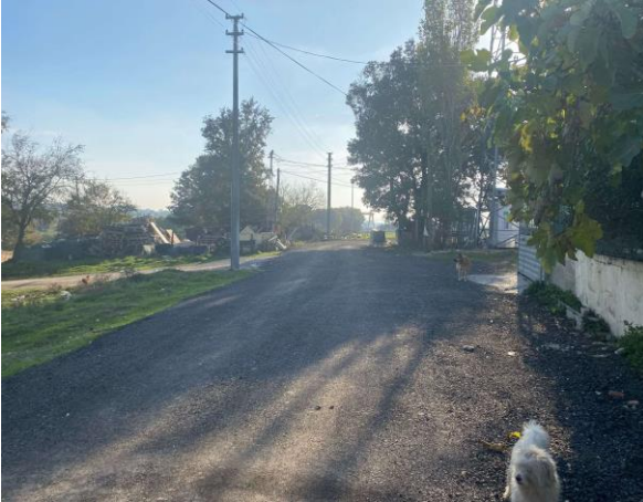
Cumhuriyet Mahallesi 2595. Sokak Asfalt Kırığı 4000 m 2
