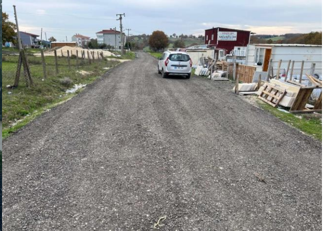
Atatürk Mahallesi Eşref Bitlis Caddesi Asfalt Kırığı 3500 m 2
