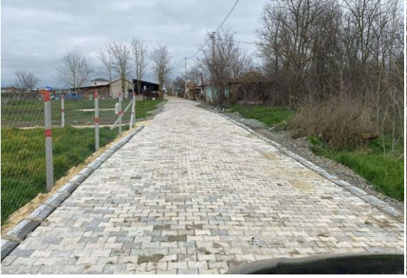
Demirler Mahallesi 4202. Sokak Kilitli Parke 3000 m 2
