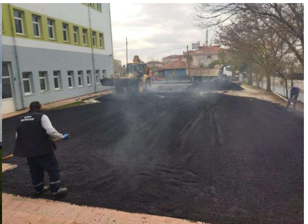
Kurtdere Mahallesi Okul Bahçesi Sıcak Asfalt 650 m 2
