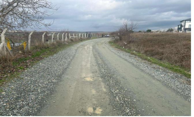
Yeni Mahalle Şubat Sokak Stablize 6250 m 2
