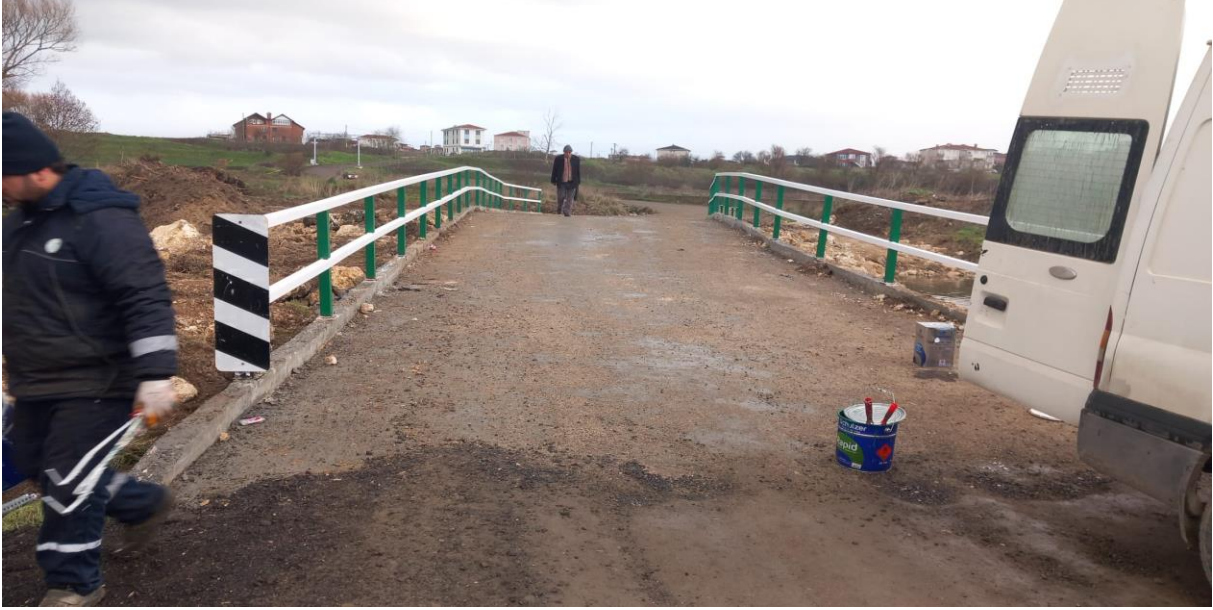
Edirköy Mahallesi Yolu Üzeri Köprü Korkuluğu Yapımı ve Montajı
